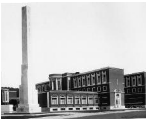
Una veduta del Foro Italo, sede del CONI
